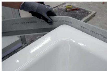
Fig. 18 – Incollaggio del nastro di tenuta al bordo della vasca.
