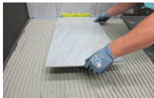
Fig. 9 – sistema di posa di strato ceramico e impermeabilizzazione
