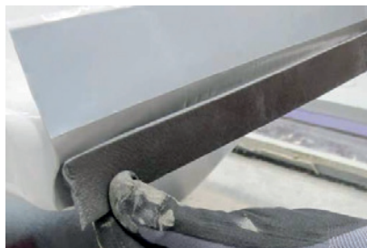
Fig. 19 – Predisposizione dell'elemento espanso in corrispondenza del nastro
