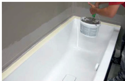
Fig. 21 - Ultimazione dei lavori di sigillatura
